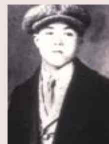
東京湯島の修理工場「アート商会」の、丁稚小僧時代
